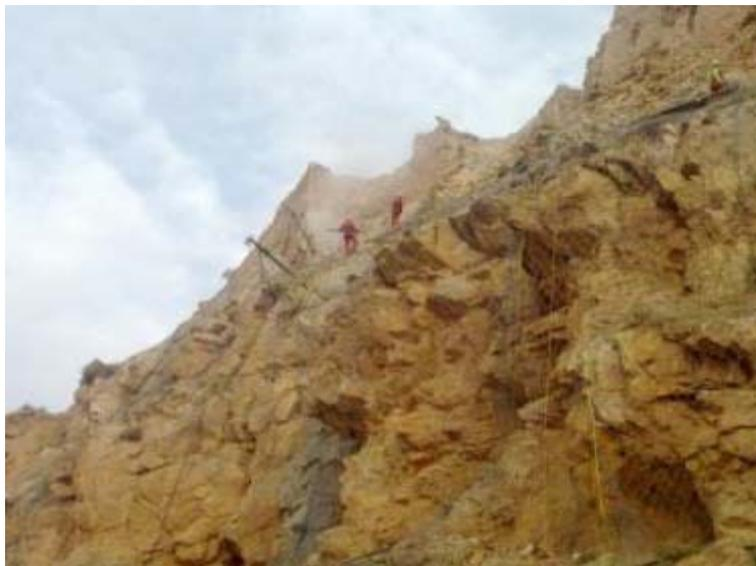
*Fotografía 6: Trabajos de ejecución de malla de estabilización*
