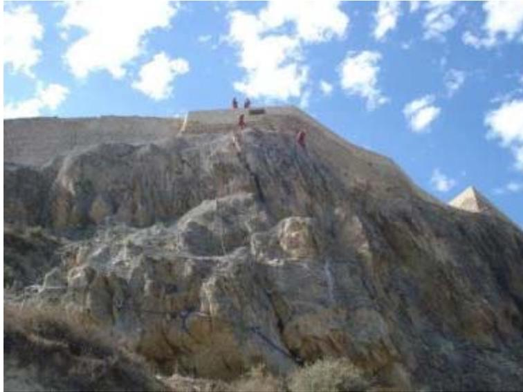
*Fotografía 5: Trabajos de ejecución de malla de estabilización*
