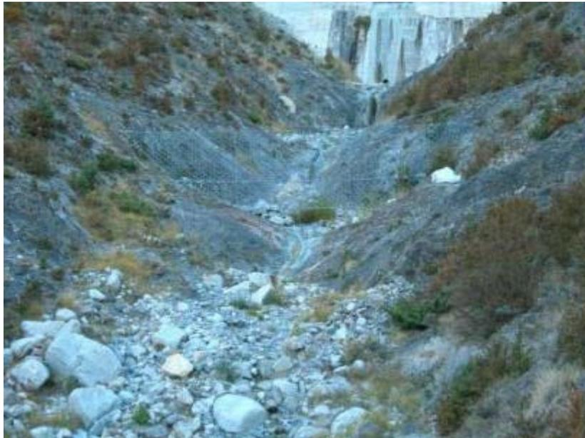
*Fotografía 45: Barrera de flujo de derrubios ejecutada*
