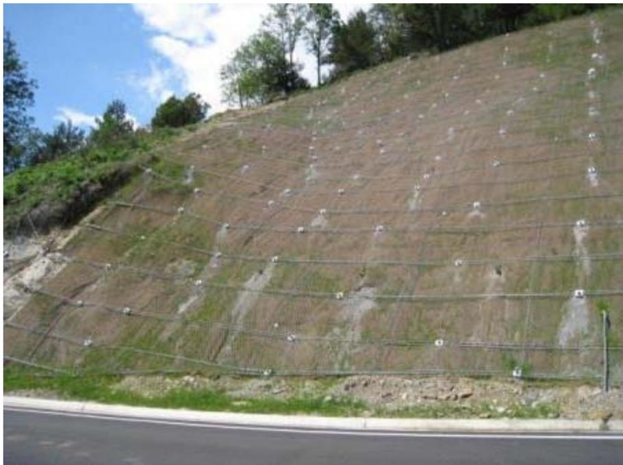
*Fotografía 48: Malla de estabilización ejecutada*
