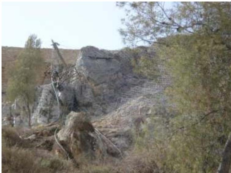
*Fotografía 8: Trabajos de ejecución de malla de estabilización*
