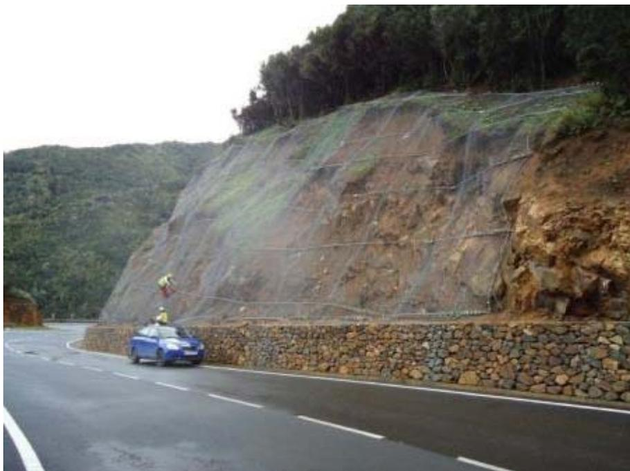
Fotografía 38: Malla de estabilización ejecutada
