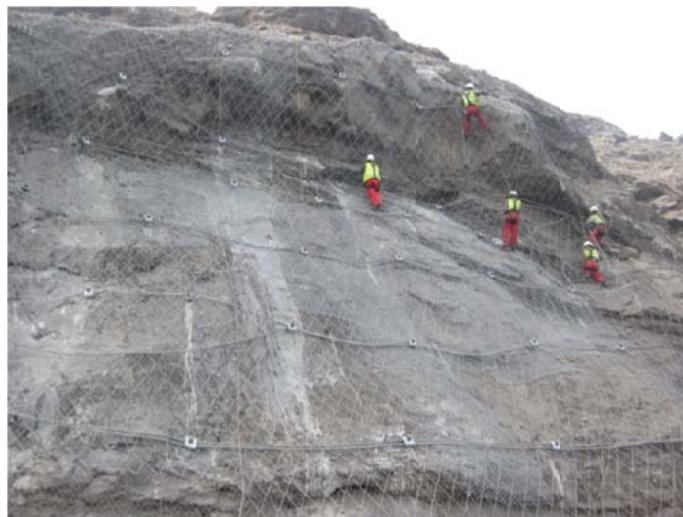
Fotografía 29: Ejecución de malla de estabilización
