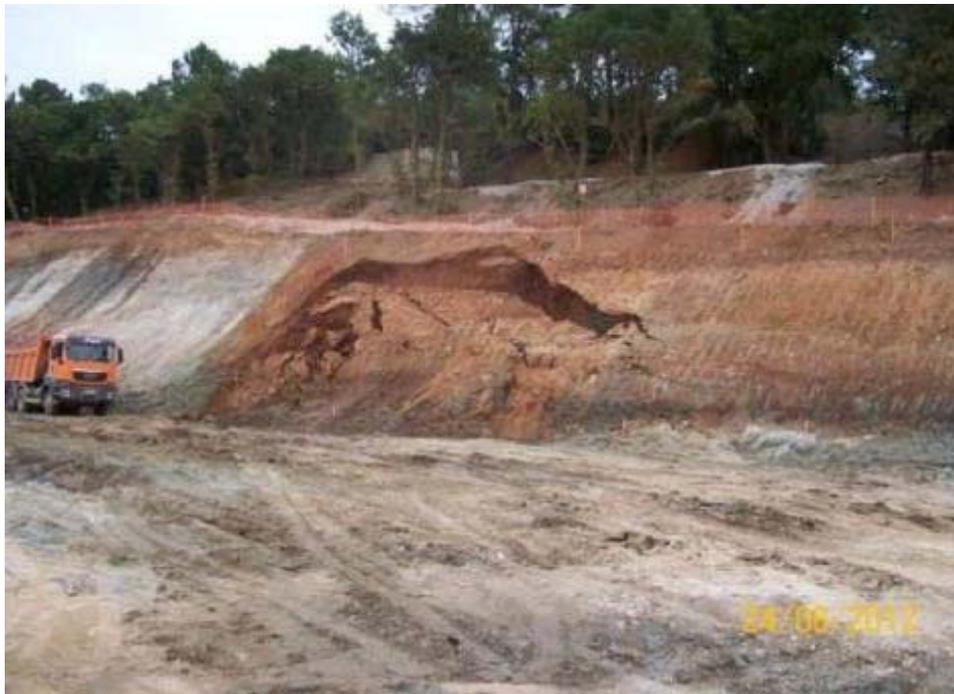
*Fotografía 66: Deslizamiento del talud*
