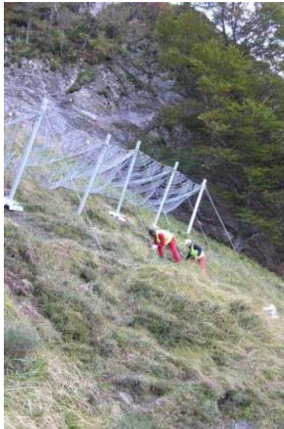
*Fotografía 42: Ejecución barreras antialudes*
