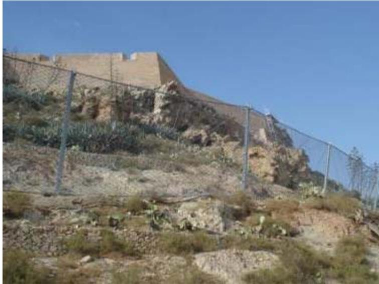
*Fotografía 3: Situación después de la instalación de barreras dinámicas de protección contra desprendimientos*
