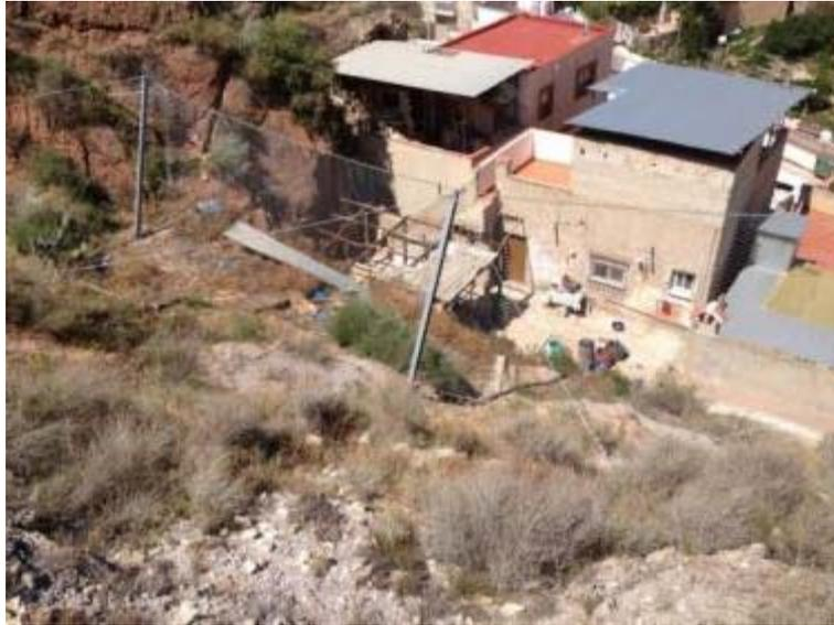
*Fotografía 11: Situación después de la instalación de barreras dinámicas de protección contra desprendimientos*
